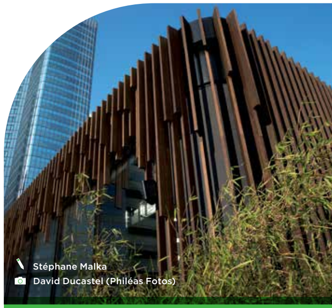
Oxygen La Défense Paris - Bamboo X-treme® Balken geïnstalleerd op een gevel met verschillende lengtes en diktes - (5500 m 2 ) Parijs, Frankrijk
